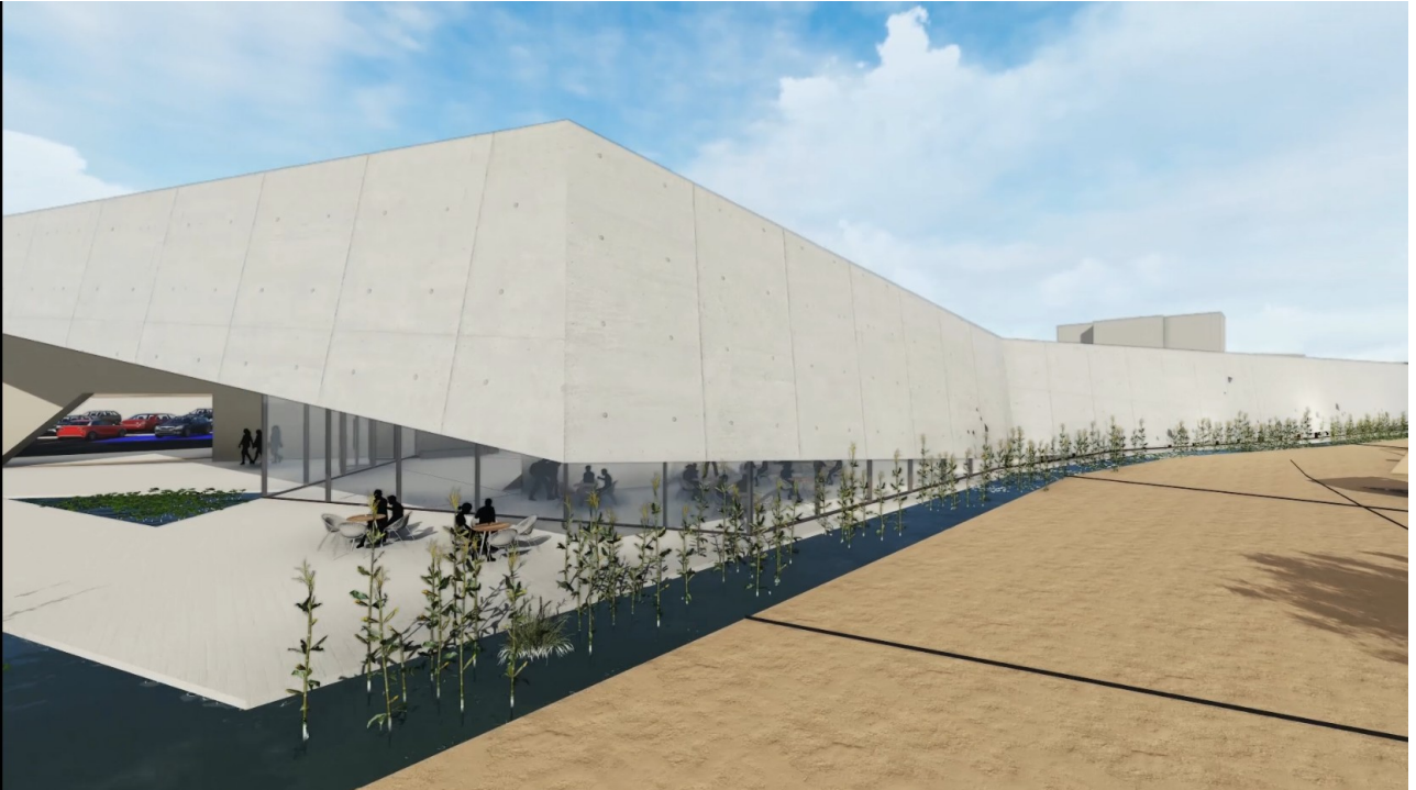
תעלת מים צמודה לדופן המערבית הארכה של הפרויקט , תולן מוארך ועד צמוד לרצפה, מכניסים למבנה רוח מערבית קרירה יחסית אשר מקוררת אף יותר במעבריה מעל תעלת המים. כאשר שורת חלונות עליונים בקיר הגנדי המזרחי מולטים את האויר שהתחמם בחלל המבנה, תנועת האויר משפרת את תחושת הנחות התרמית של השוורים בפרויקט, החלונות – הנמוכים והגבוהים- נפתחים באופן ממוחשב על ידי חישיני סמפרטורה, הן במשך היום – שהטמפרטורות מתאימות- והן בלילות הקרירים.
